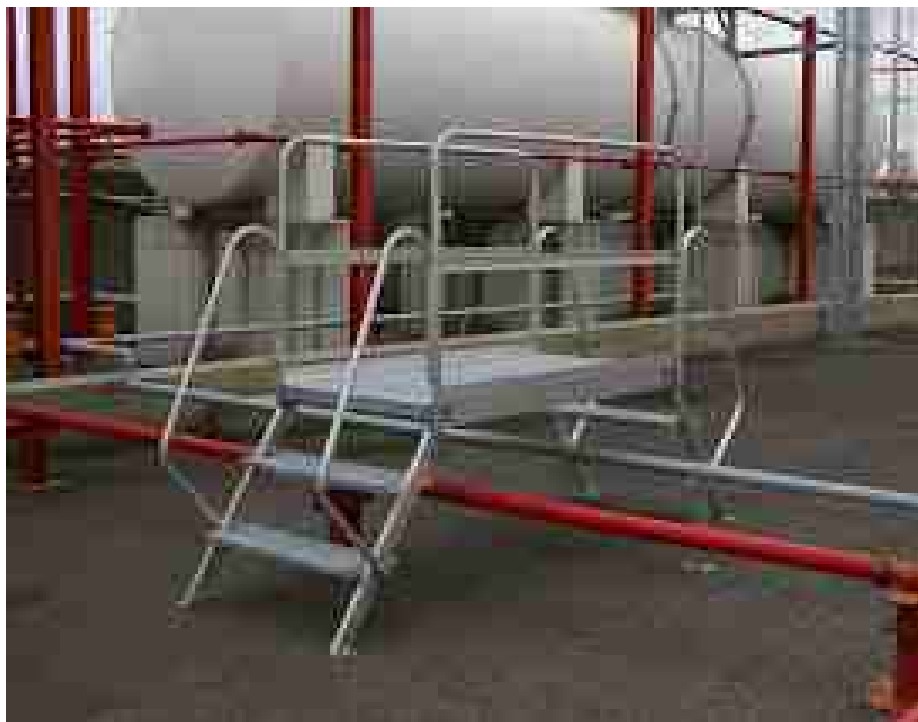
- Plataforma de trabajo para acceso a llaves.
