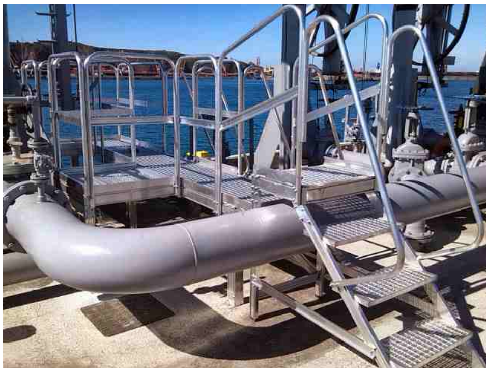
- Escalera de acceso con barandilla
