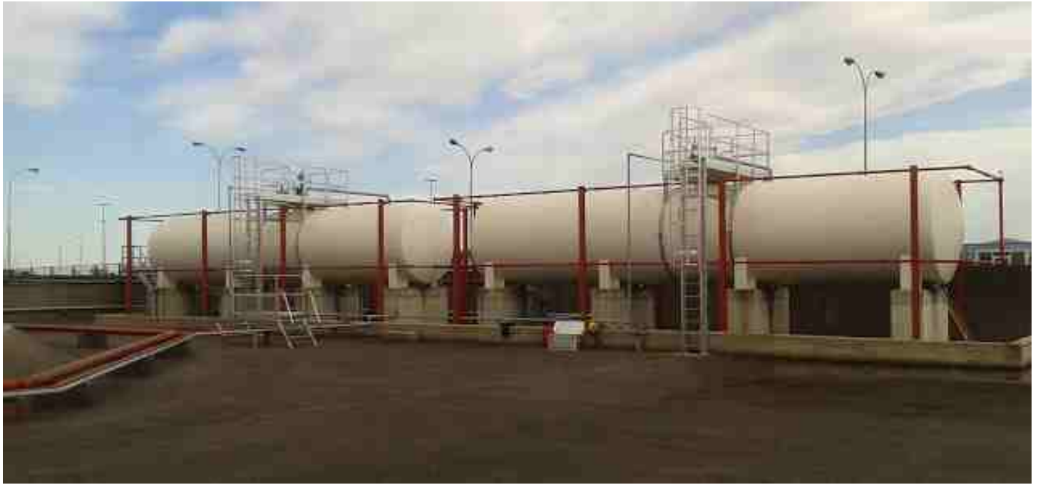
- Escaleras verticales con aro de seguridad
