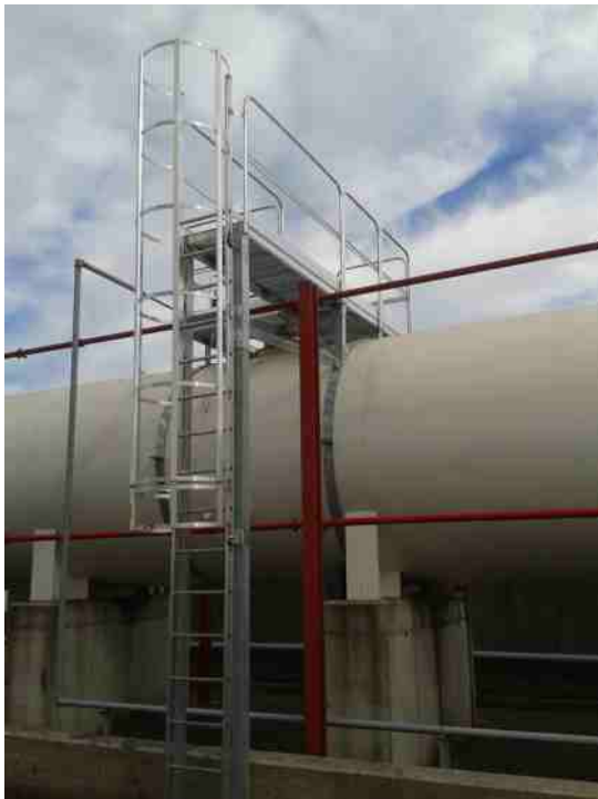
- Escaleras verticales con plataforma y barandillas.
