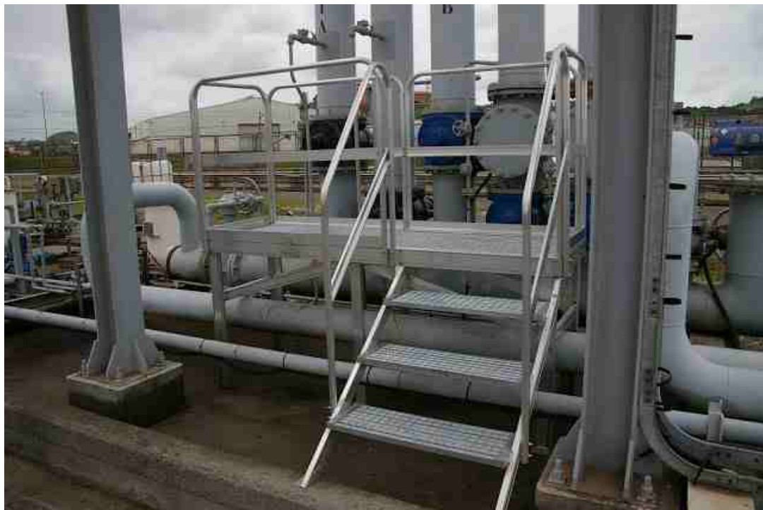
- Escalera de acceso con peldaños en tramex.
