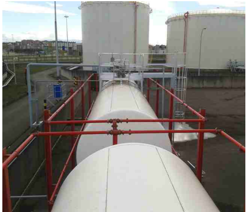
- Escaleras verticales con plataforma y barandillas.
