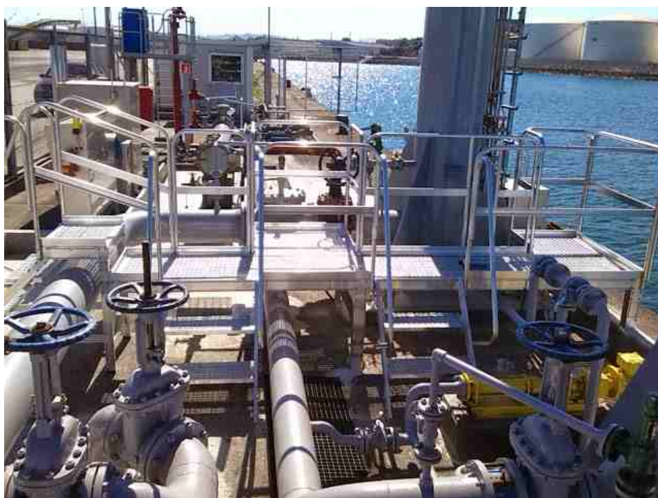
- Plataforma distribuidora con barandillas de seguridad.
