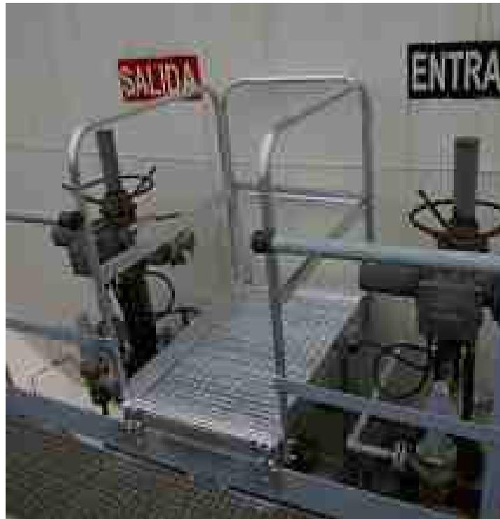
- Plataforma de trabajo para acceso a llaves.
