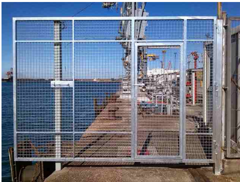
- Escalera de acceso con peldaños en tramex.
