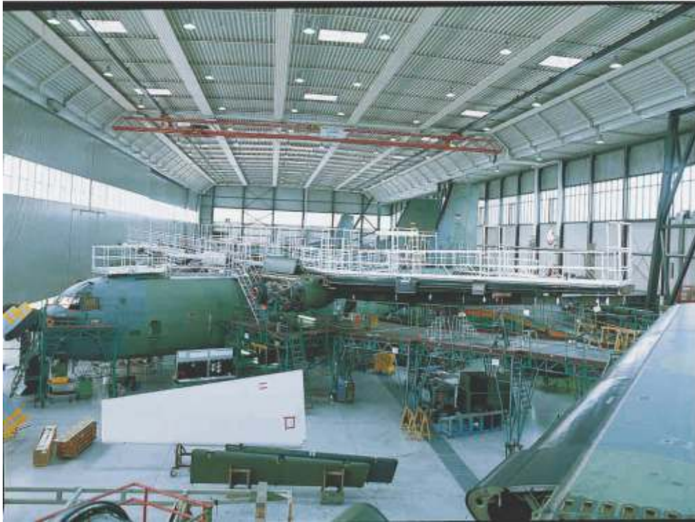
- Estructura para mantenimiento de aviones y subida hacia el fuselaje.
