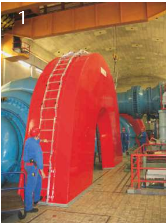
- (1) Escalera especial para mantenimiento alrededor de estructuras circulares suministrada con articulaciones especiales.
