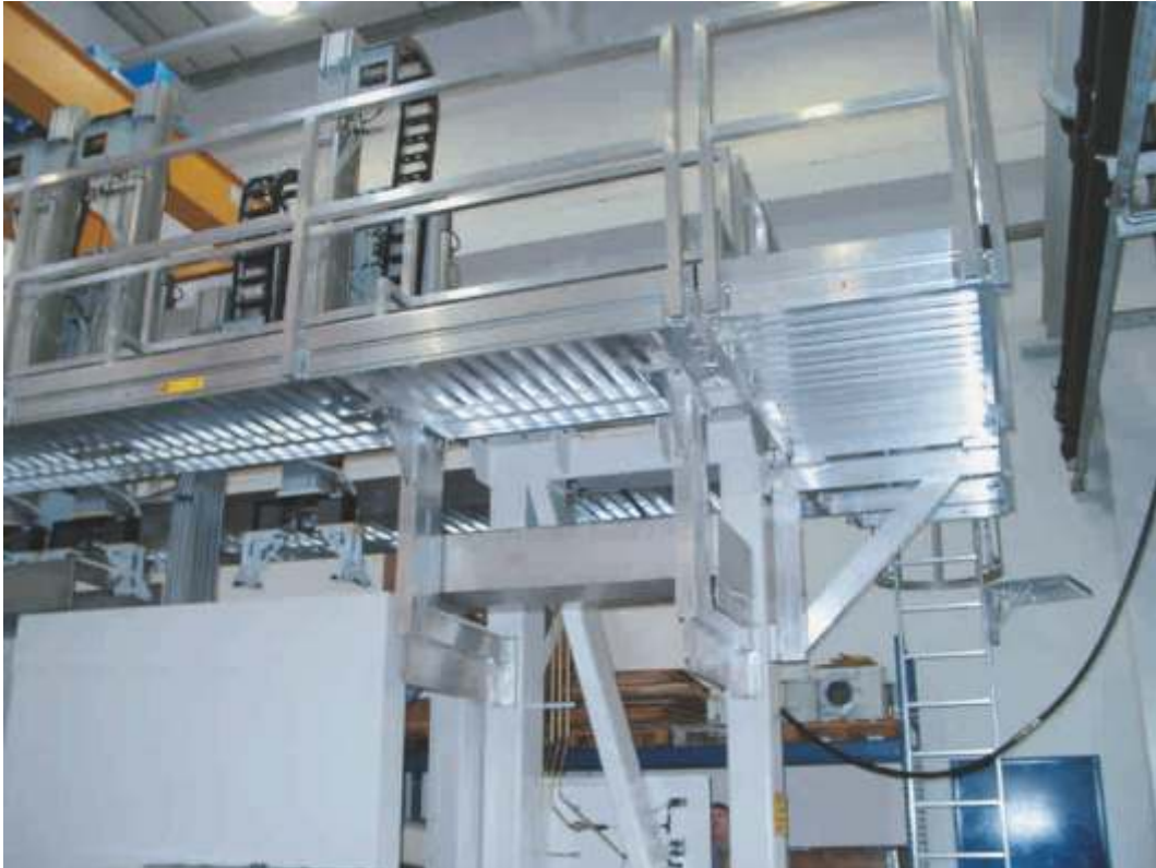
- Sistema de pasarela con subida a través de escalera con travesaños.
